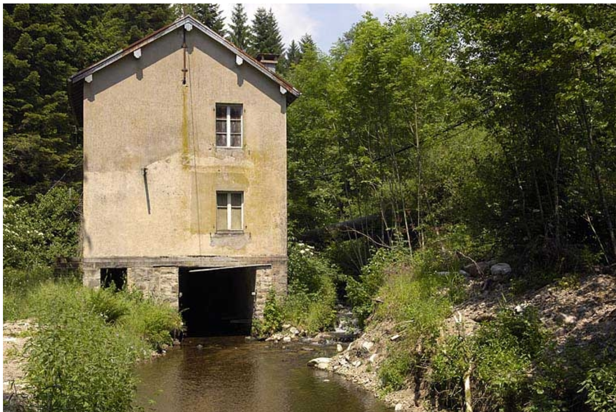
Vue depuis l'aval.
