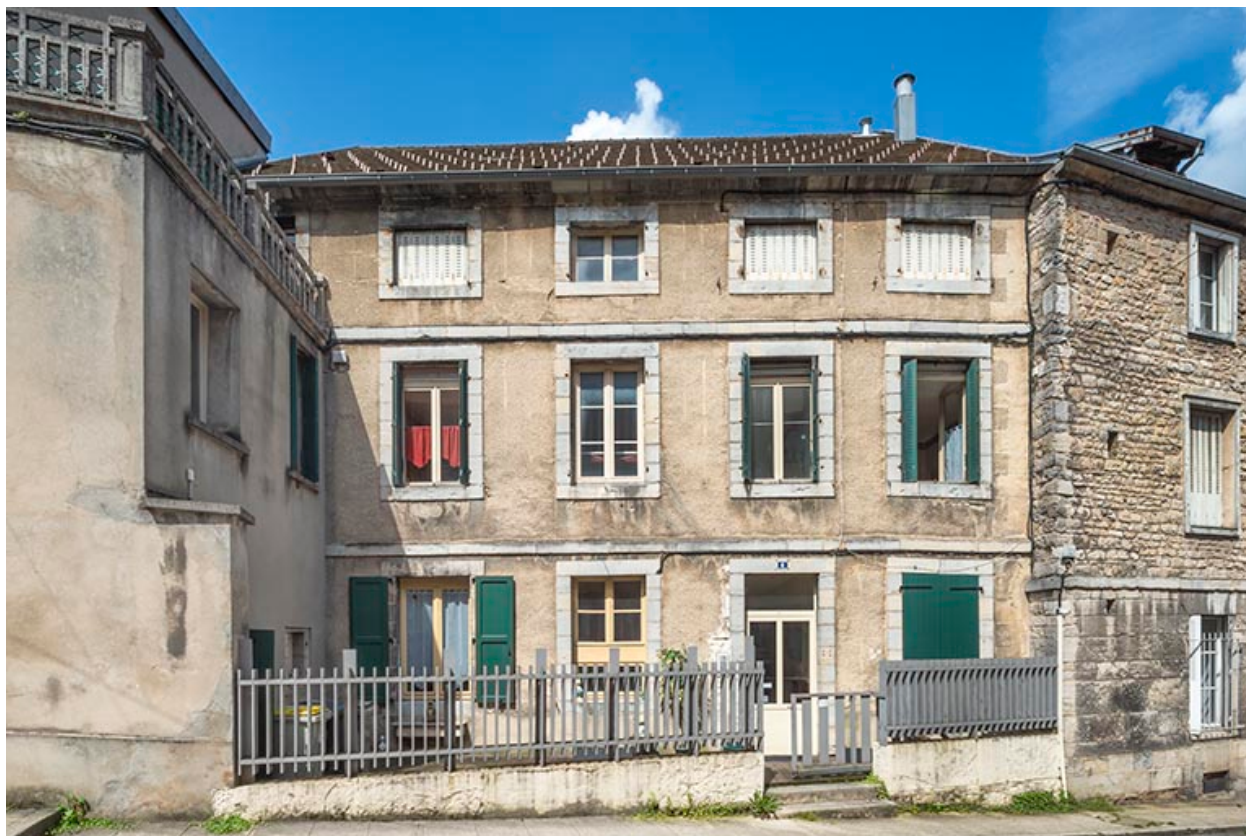
Façade postérieure (rue Charles David).
