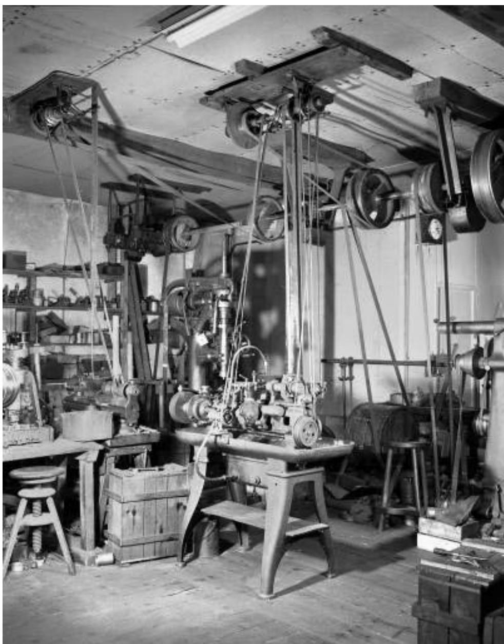
Usine d'horlogerie Arsène Cretin-l'Ange puis de matériel d'équipement industriel des Anciens Ets Charles Peccaud, Morbier (94-98 route Blanche) : intérieur de l'atelier avec un tour automatique suisse.
