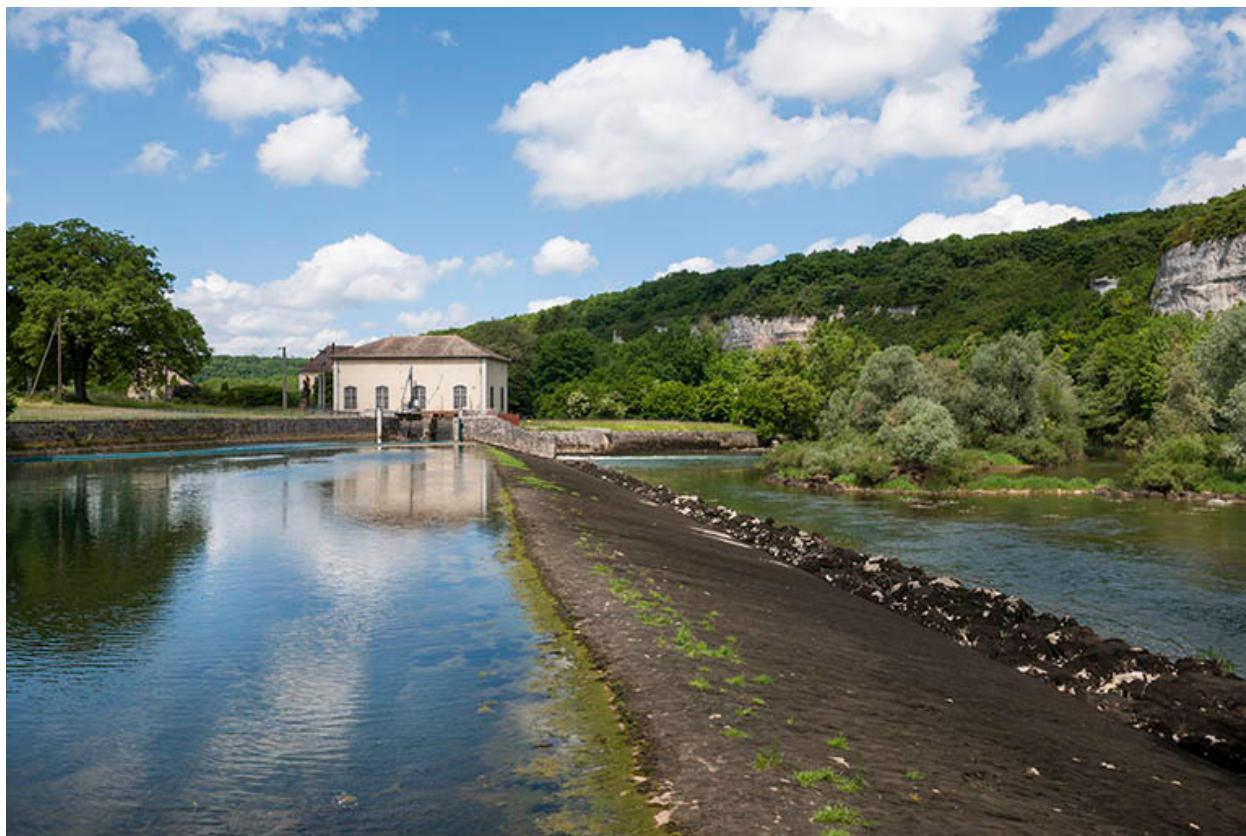
Le barrage de la centrale hydroélectrique.
