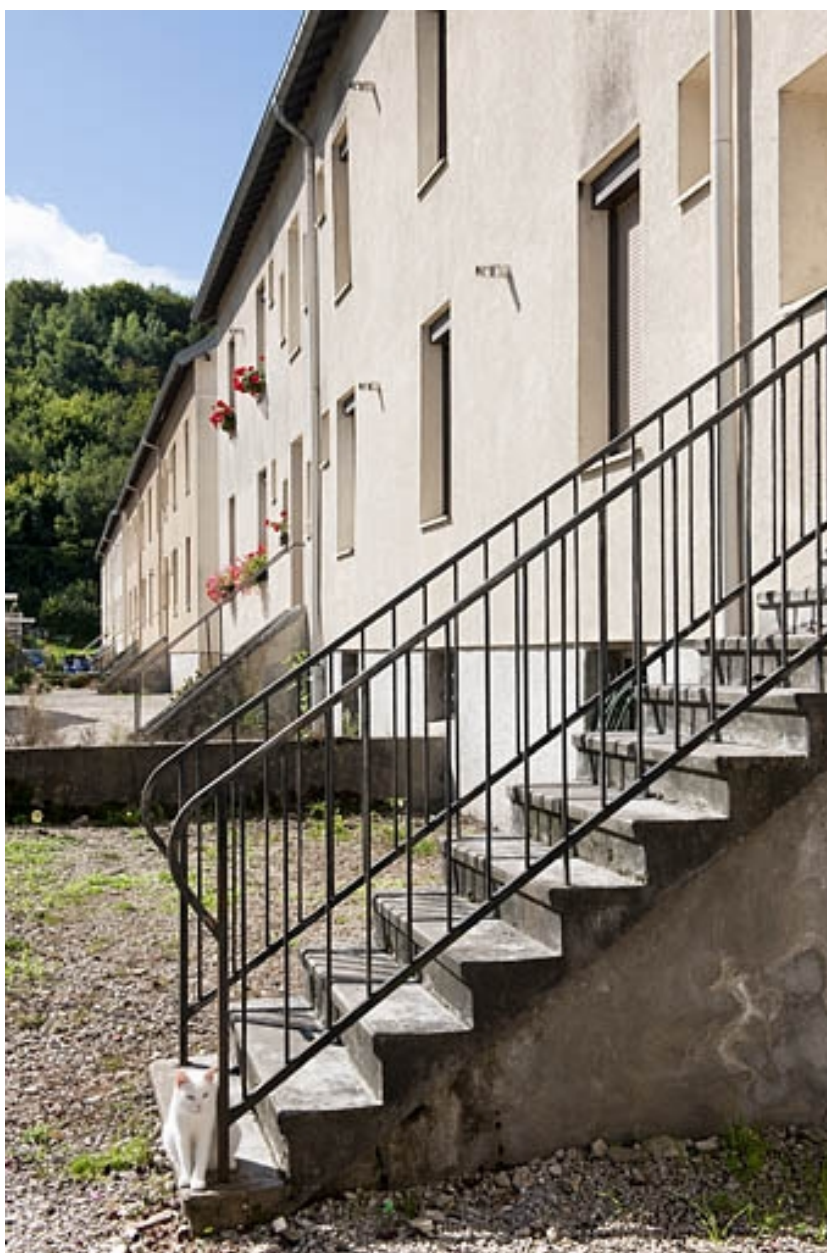
Escalier d'accès au jardin.
