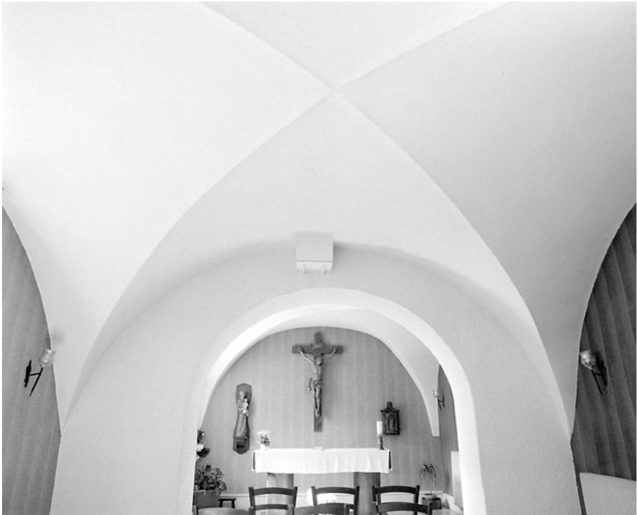
Voûte d'arêtes de la chapelle.
