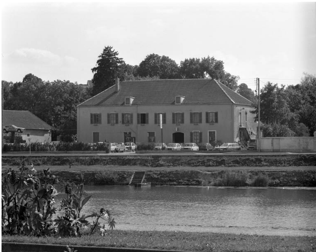
Le bâtiment principal depuis le quai Villeneuve.
