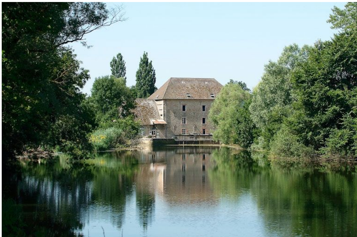
Moulin de Loisy, vu d'amont.
