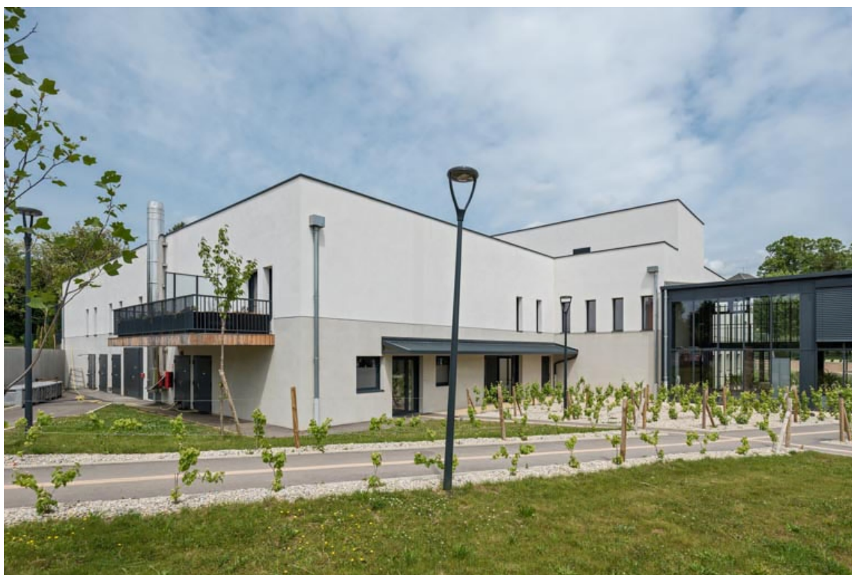
Vue depuis le sud.
