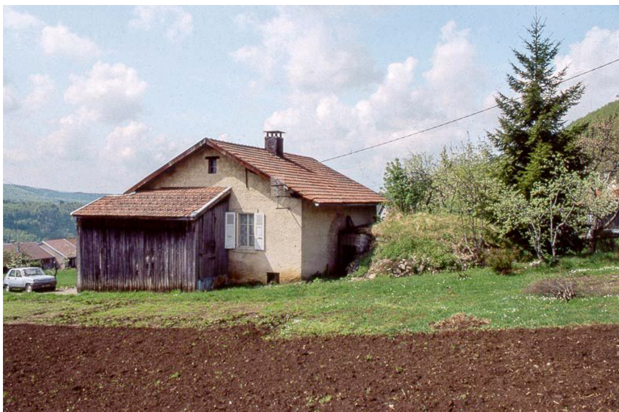
Façade postérieure et face droite.
