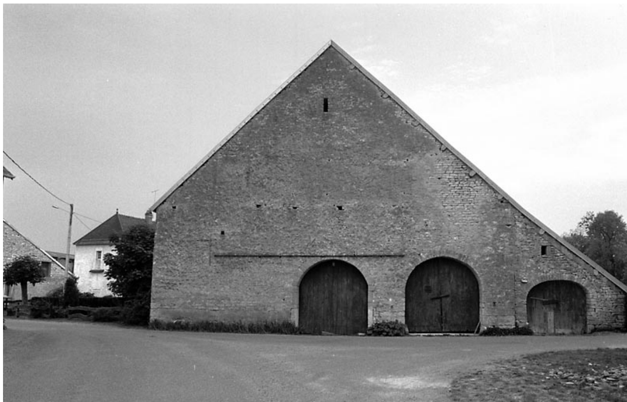
Façade latérale droite.
