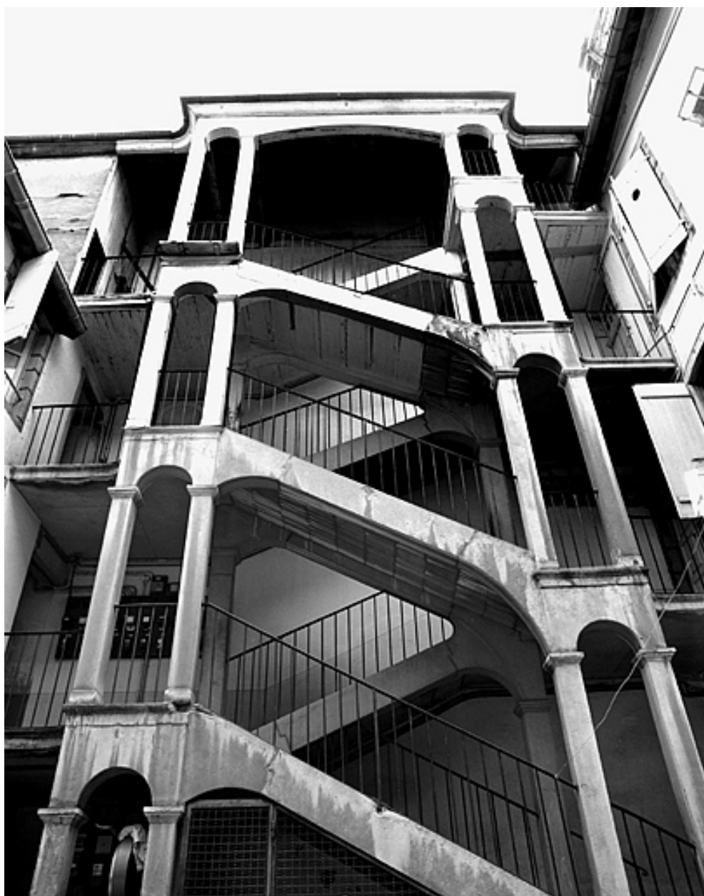
Escalier dans la cour, vue d'ensemble.
