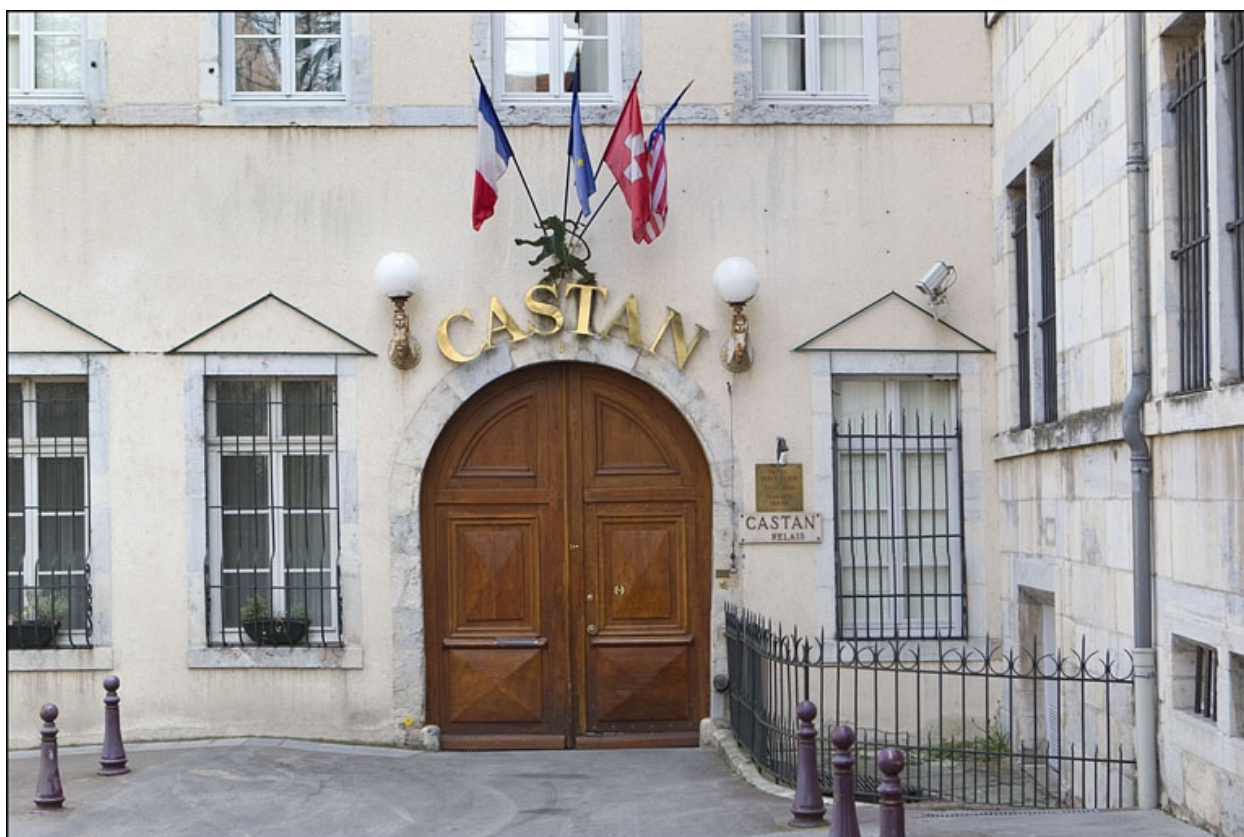
Vue du portail d'entrée sur rue.
