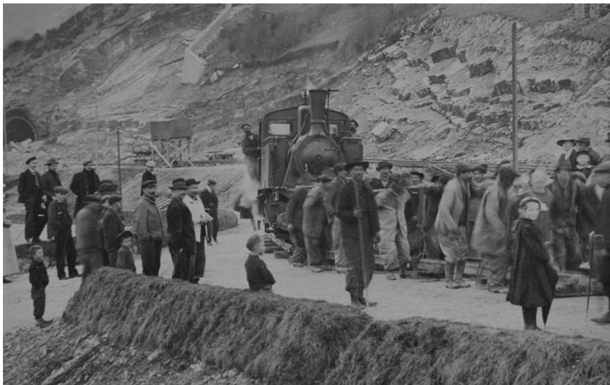
[Pose d'une voie provisoire côté Andelot-en-Montagne], 1912.
