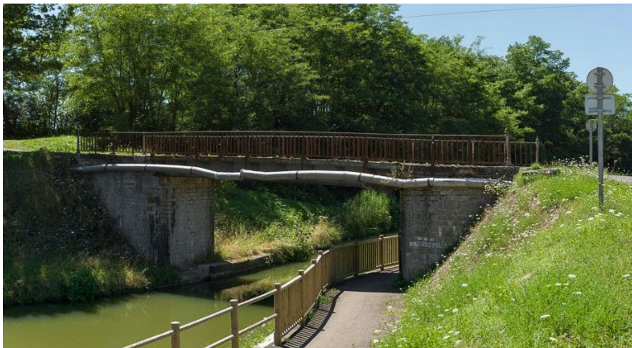
Le pont routier isolé de Paradis à Vitry-en-Charollais, vu d'amont.
