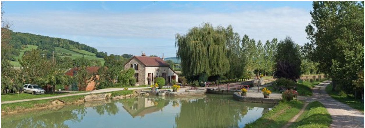
Vue du site d'écluse depuis l'amont.
