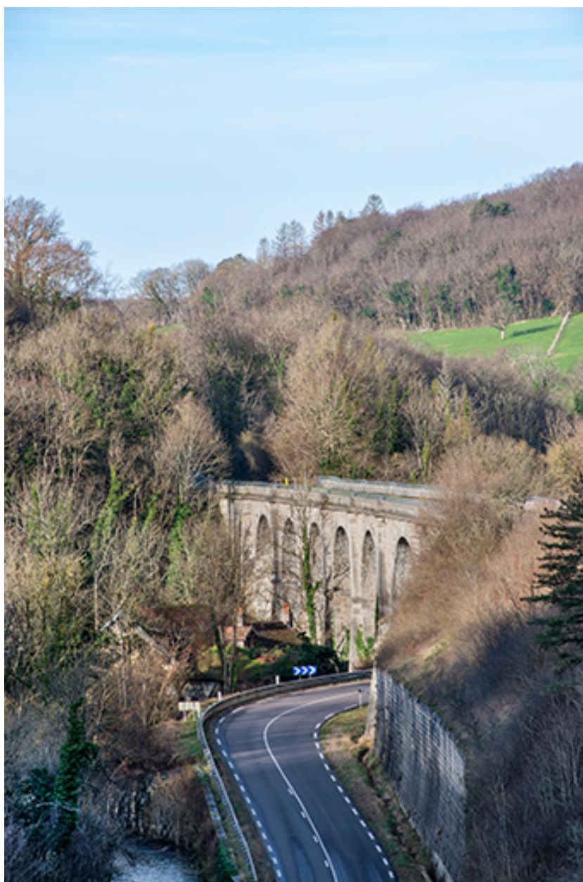
Vue rapprochée du viaduc, depuis l'est.
