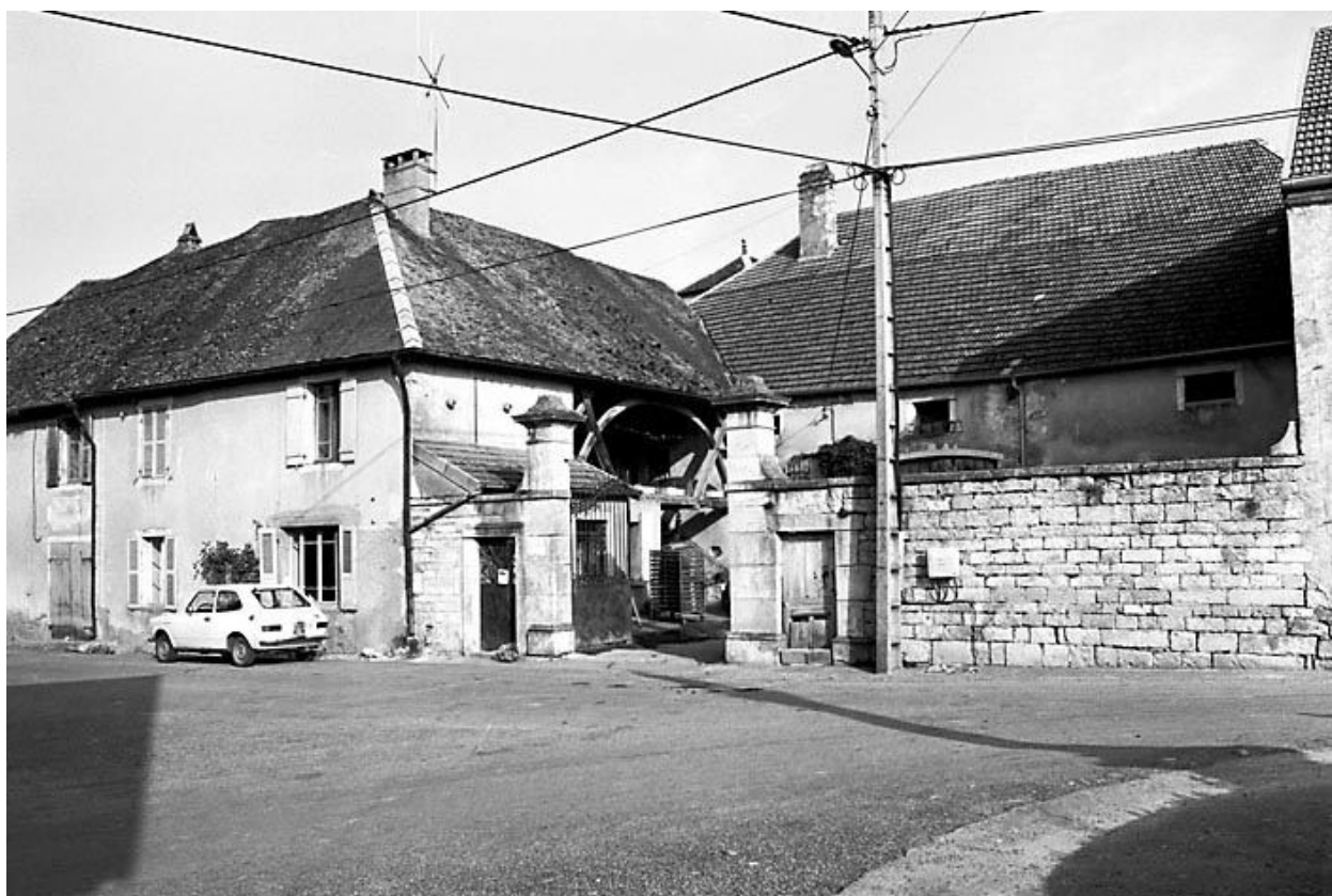
Ferme située 3 Grande Rue à Vantoux.
