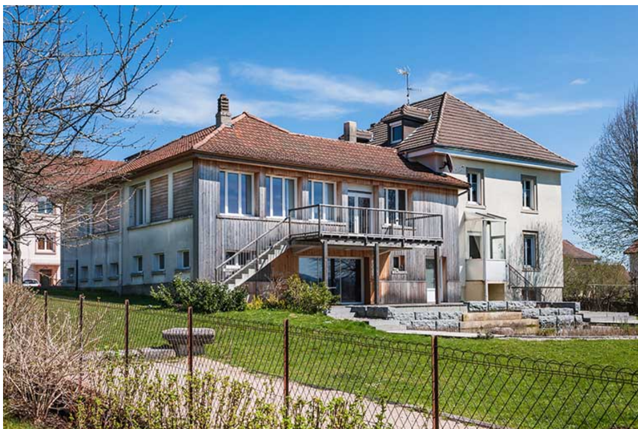
Usine : façades postérieure et latérale droite.
