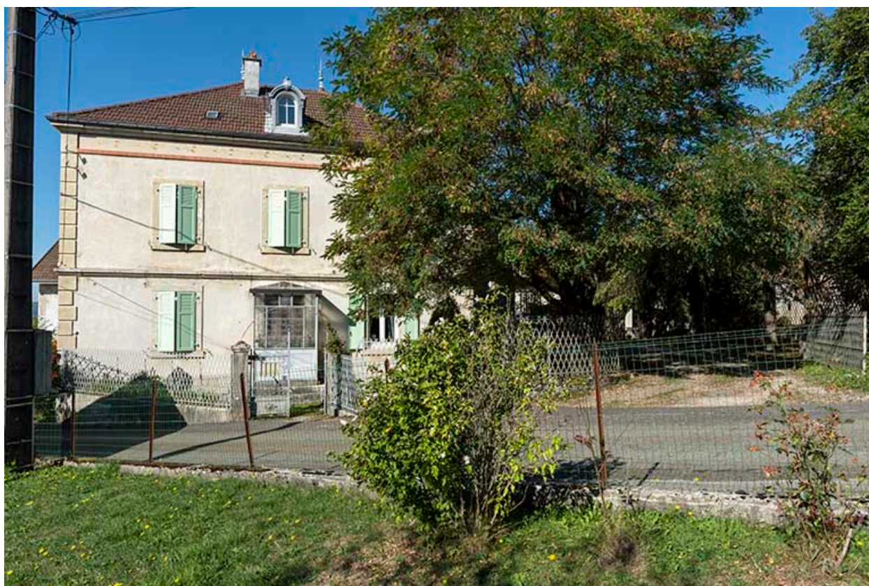
Logement Hugoniot : façade latérale droite.
