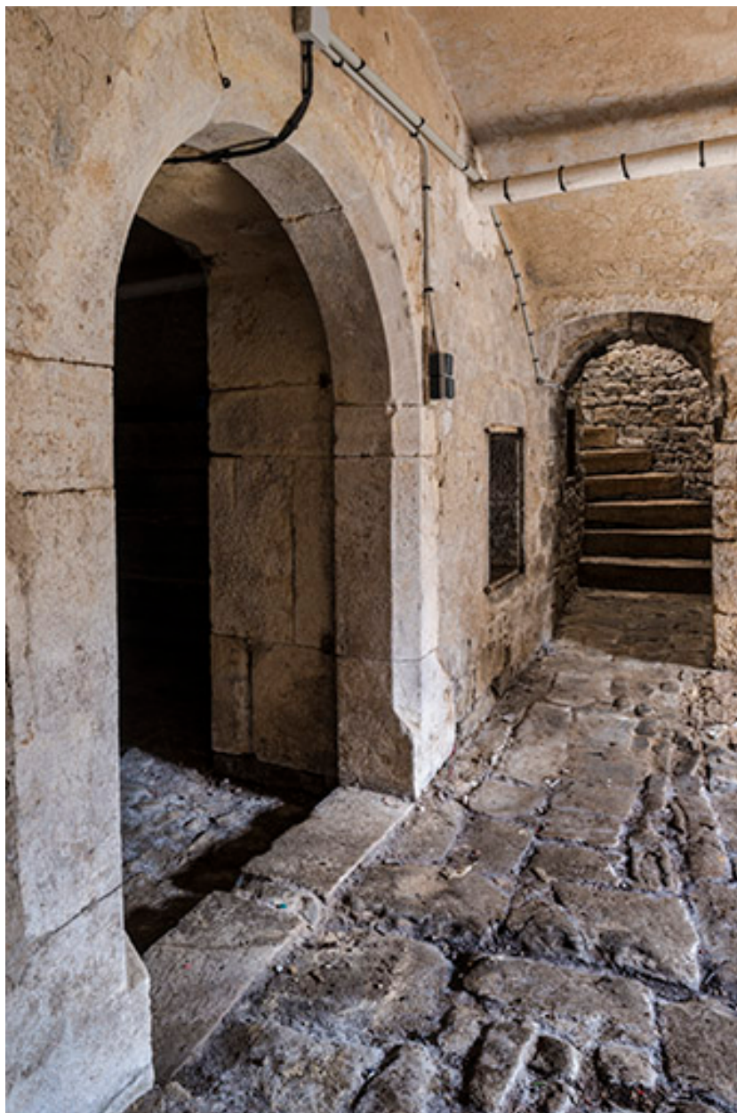
Escalier d'accès au rez-de-chaussée de la maison.
