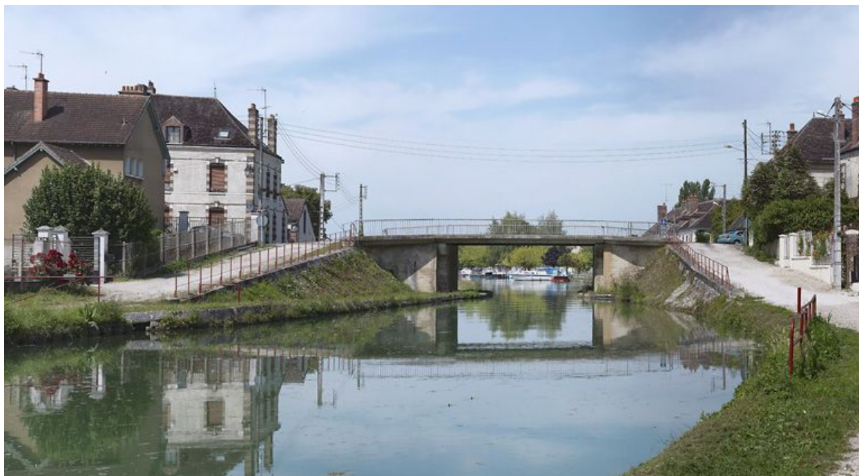
Vue d'ensemble prise d'aval.
