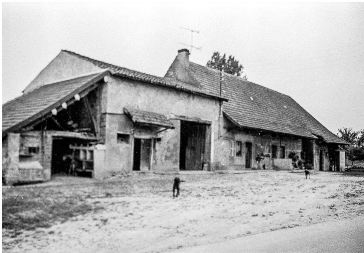
Ferme cadastrée 1969 AM 8 : façade antérieure.
