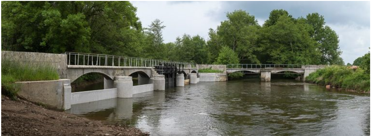
Corbigny, barrage de prise d'eau sur l'Yonne.
