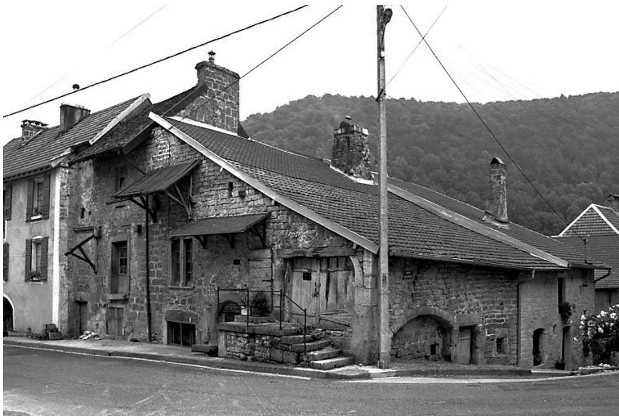
Façade antérieure et façade latérale droite.
