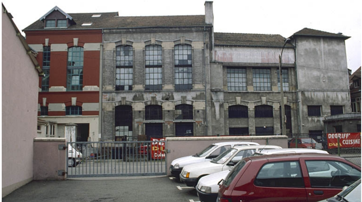
Façade antérieure de l'atelier de fabrication.
