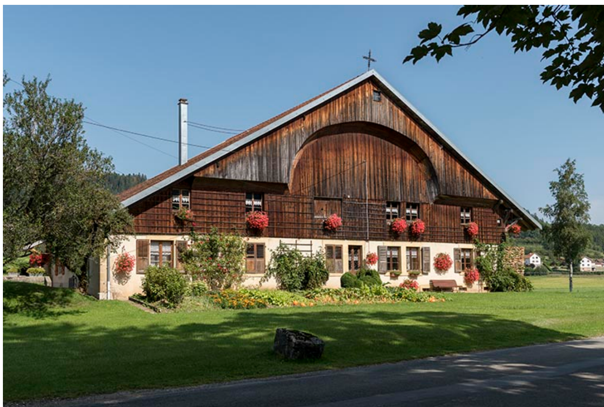
Ferme : façade antérieure, de trois quarts gauche.
