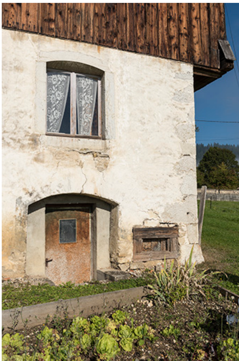
Façade est : accès au sous-sol (extension nord-est).
