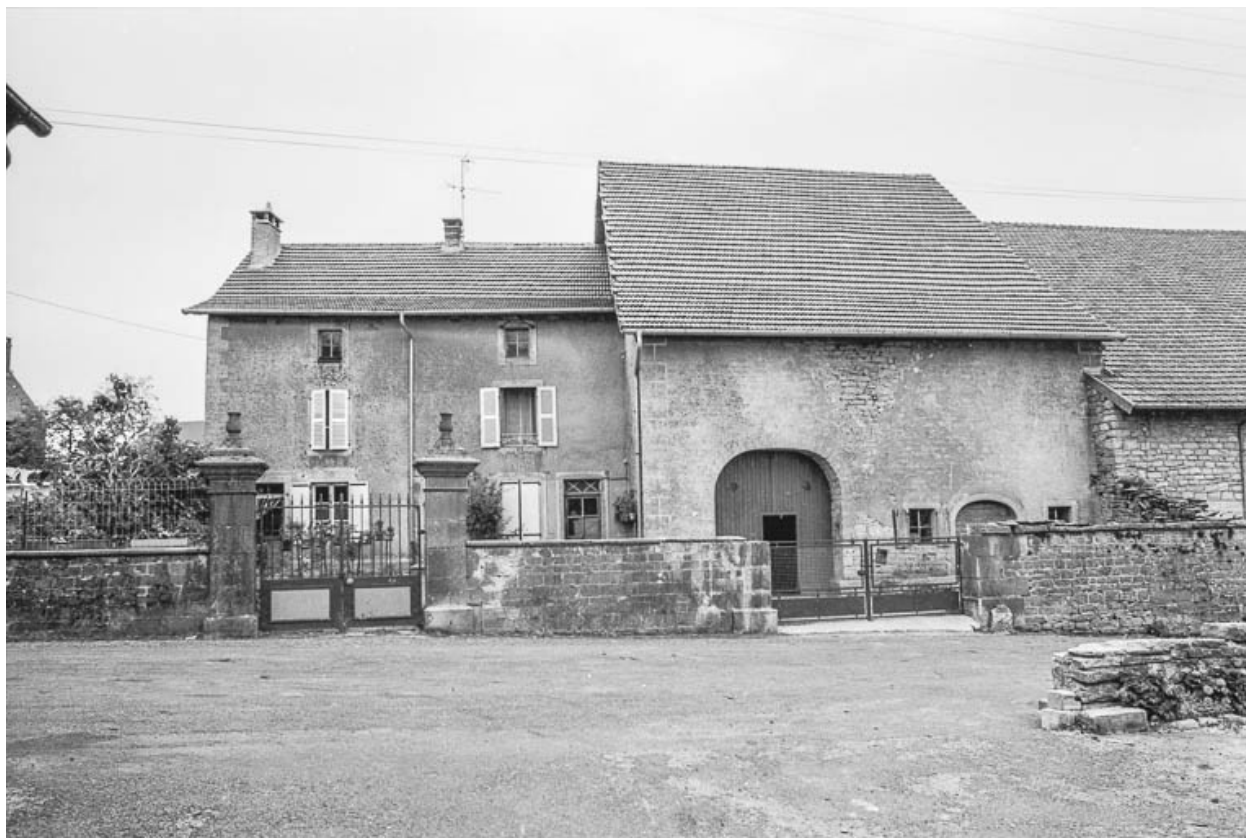
Ferme cadastrée 1951 E1 130 : façade antérieure.
