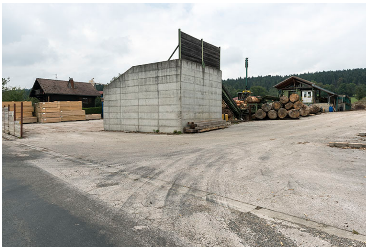
Silo, écorceuse et aire de fabrication.
