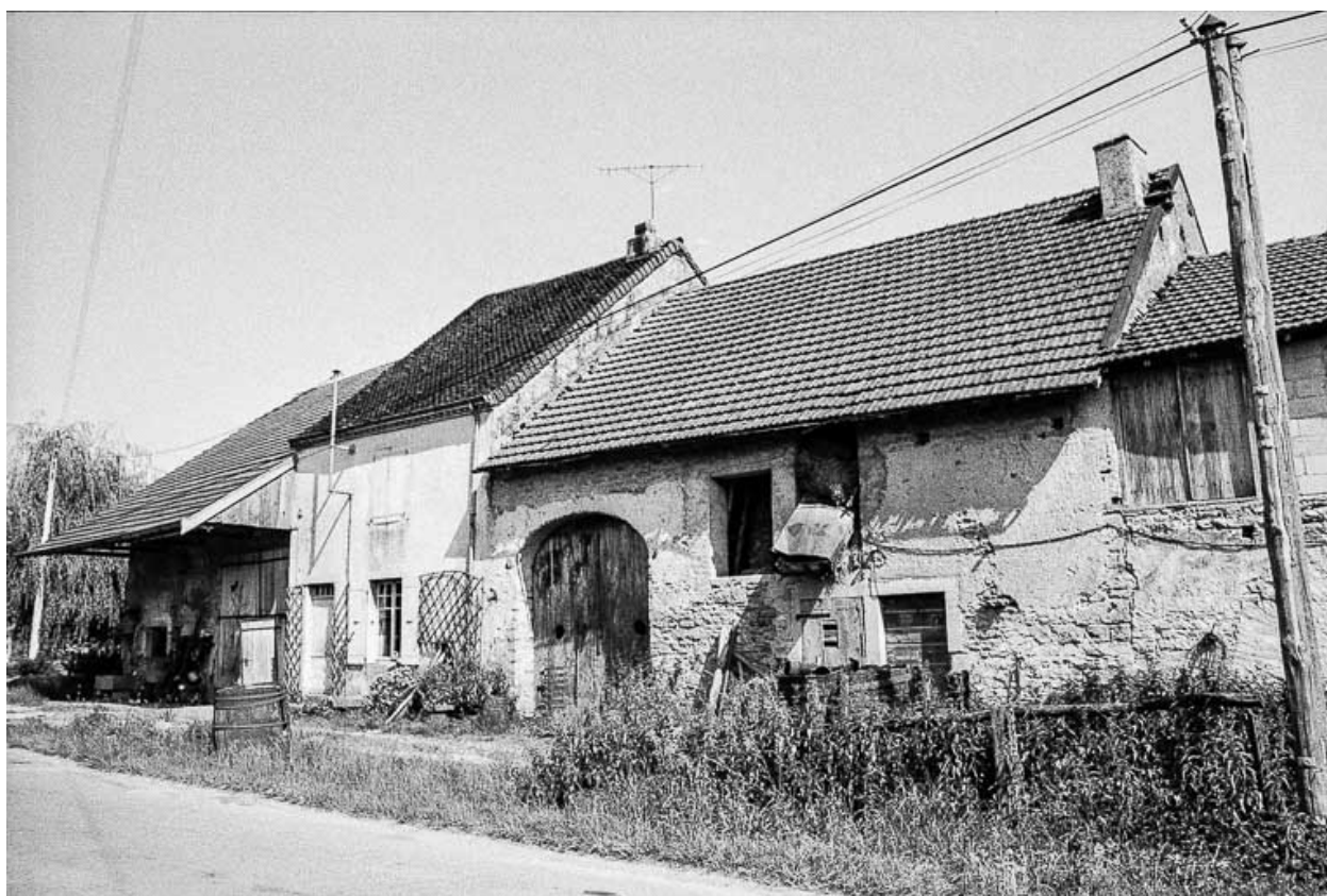
Maison cadastrée 1960 AI 8 : façade antérieure.
