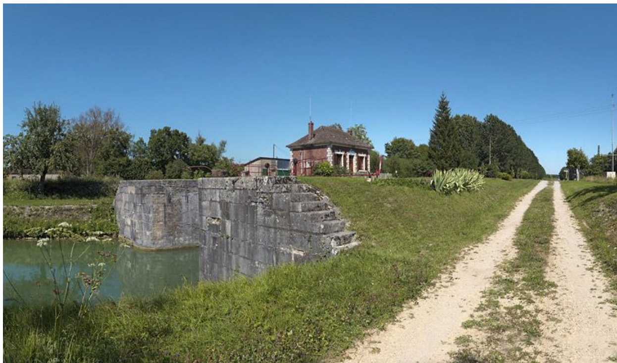
Vue de la tête amont du sas.
