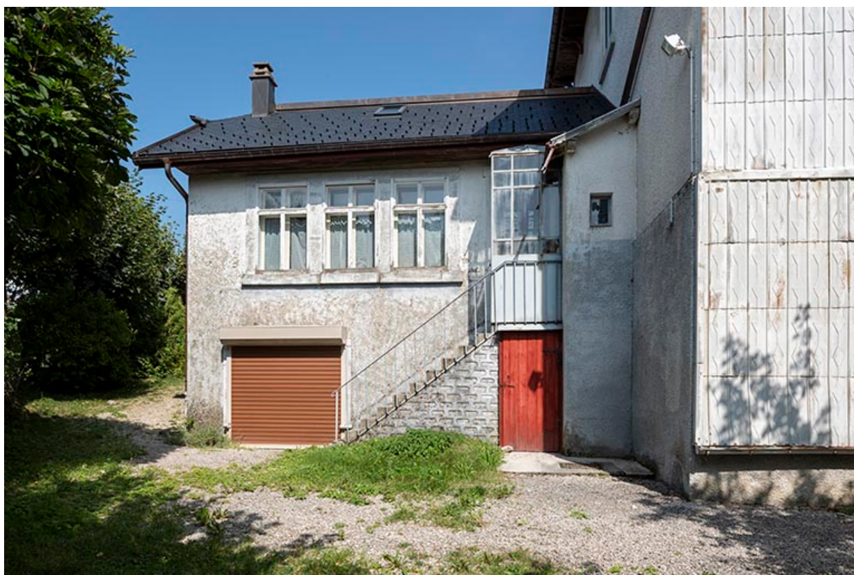
Façade postérieure de l'atelier.
