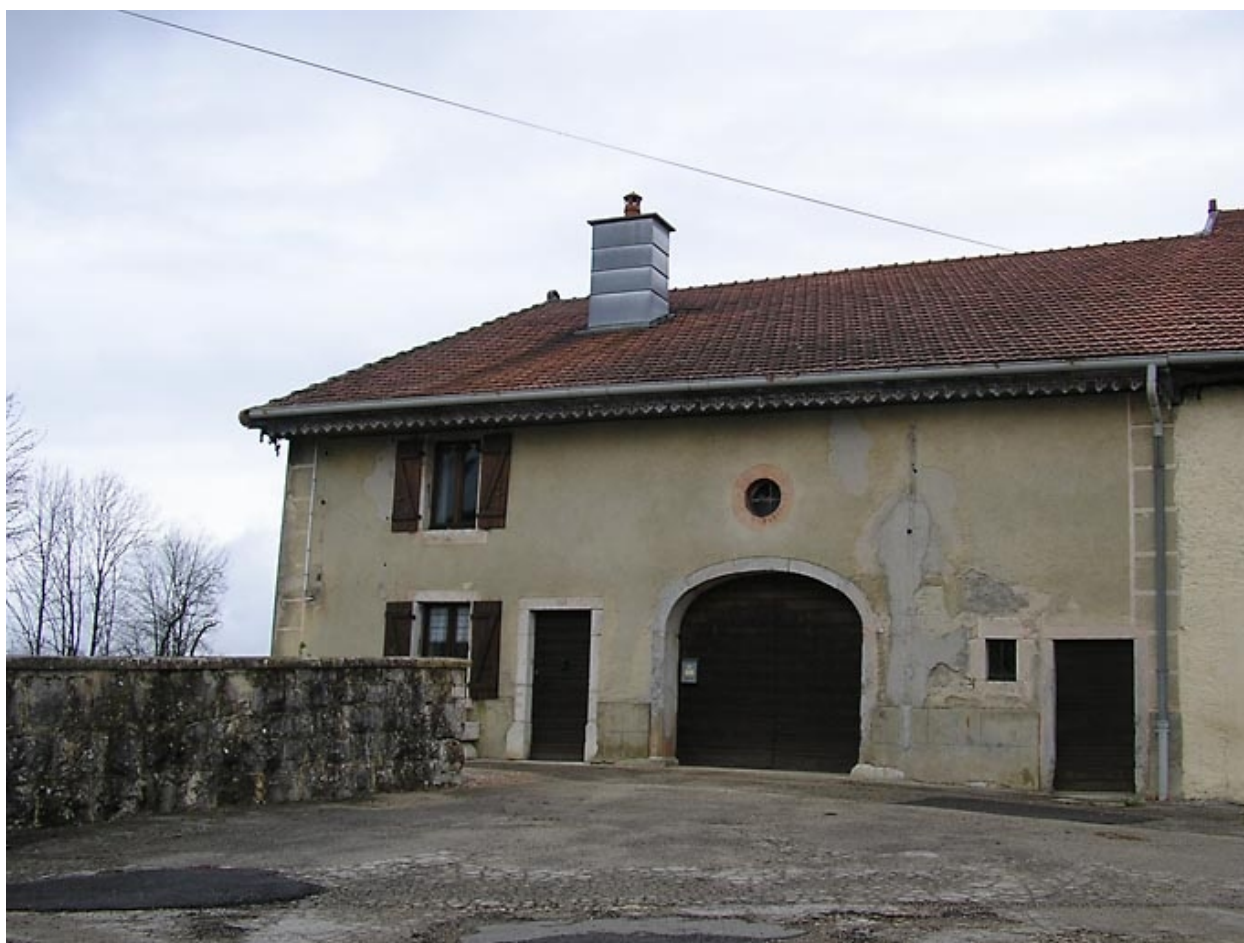
Vue générale de la façade postérieure.
