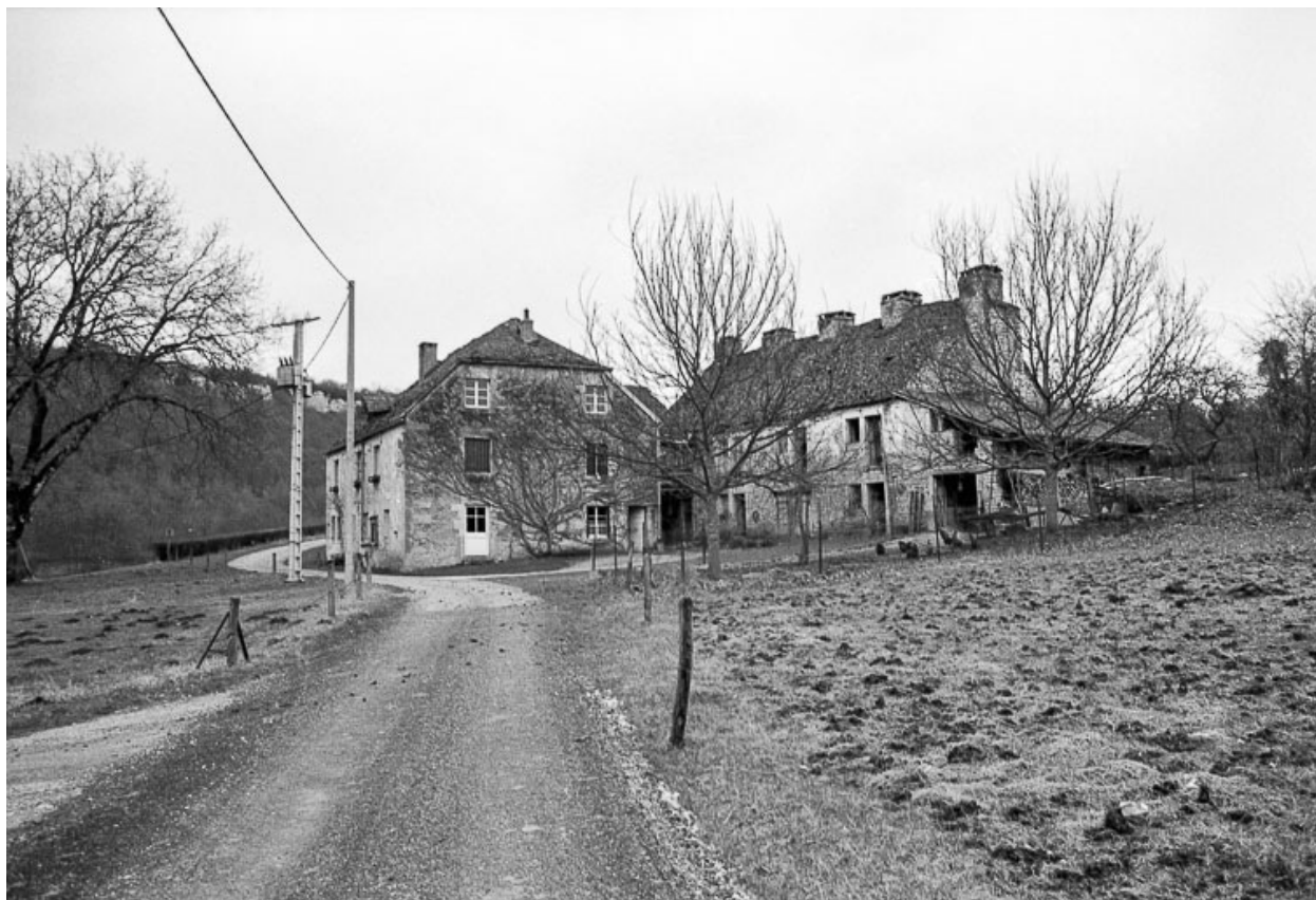
Logements d'ouvriers depuis l'ouest en 1979.
