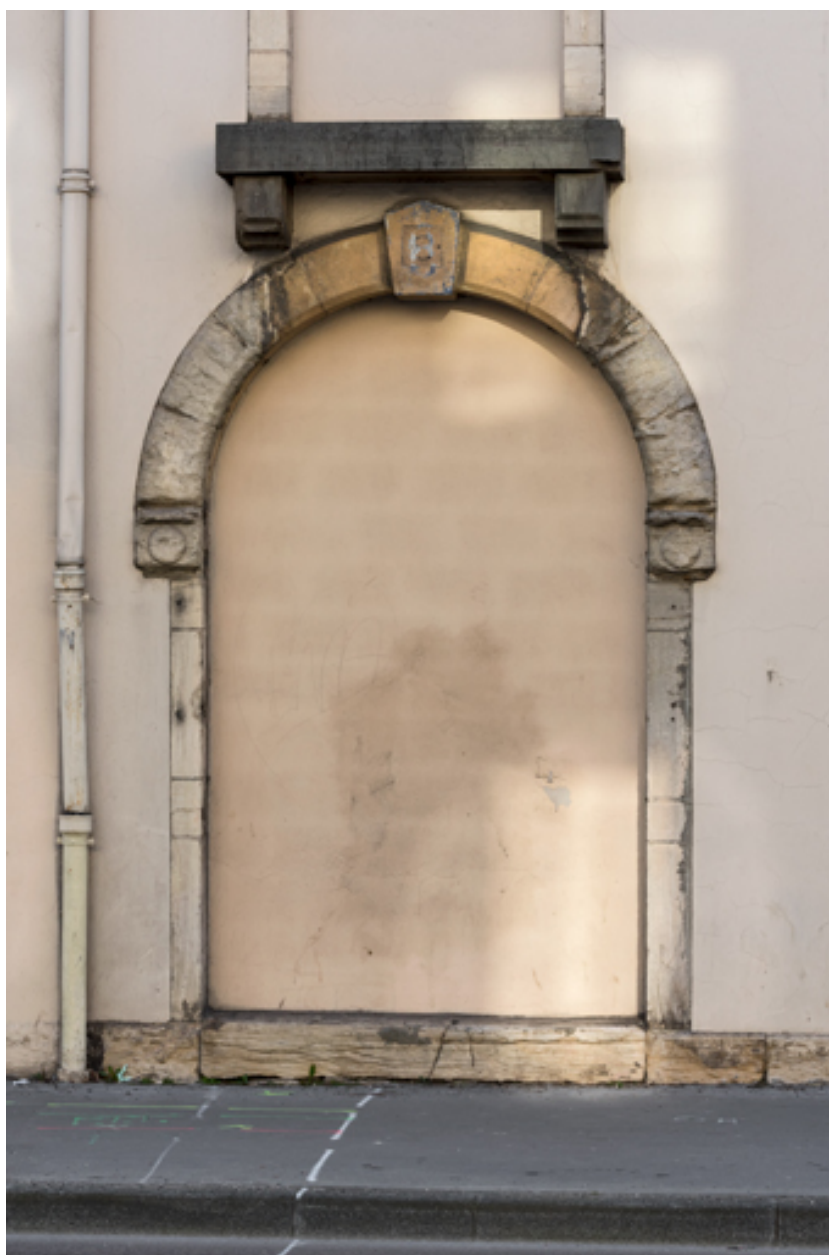
Cinéma Devosge, façade antérieure : porte murée.
