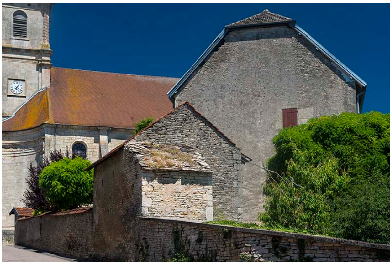
Mur pignon sud.
