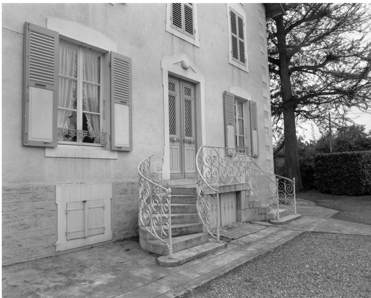
Détail du perron de l'habitation.
