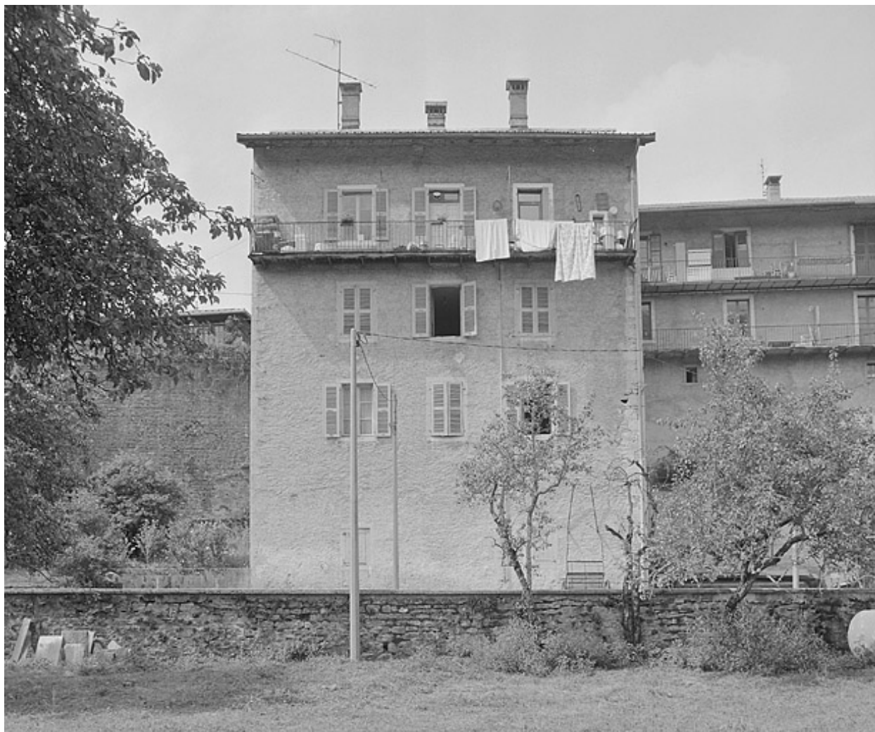
Façade postérieure de l'hôtel.
