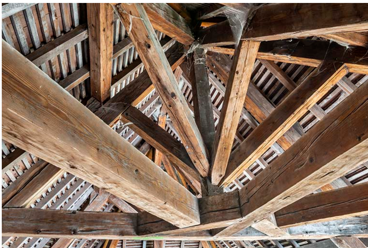
Charpente. Détail de l'enrayure sud.
