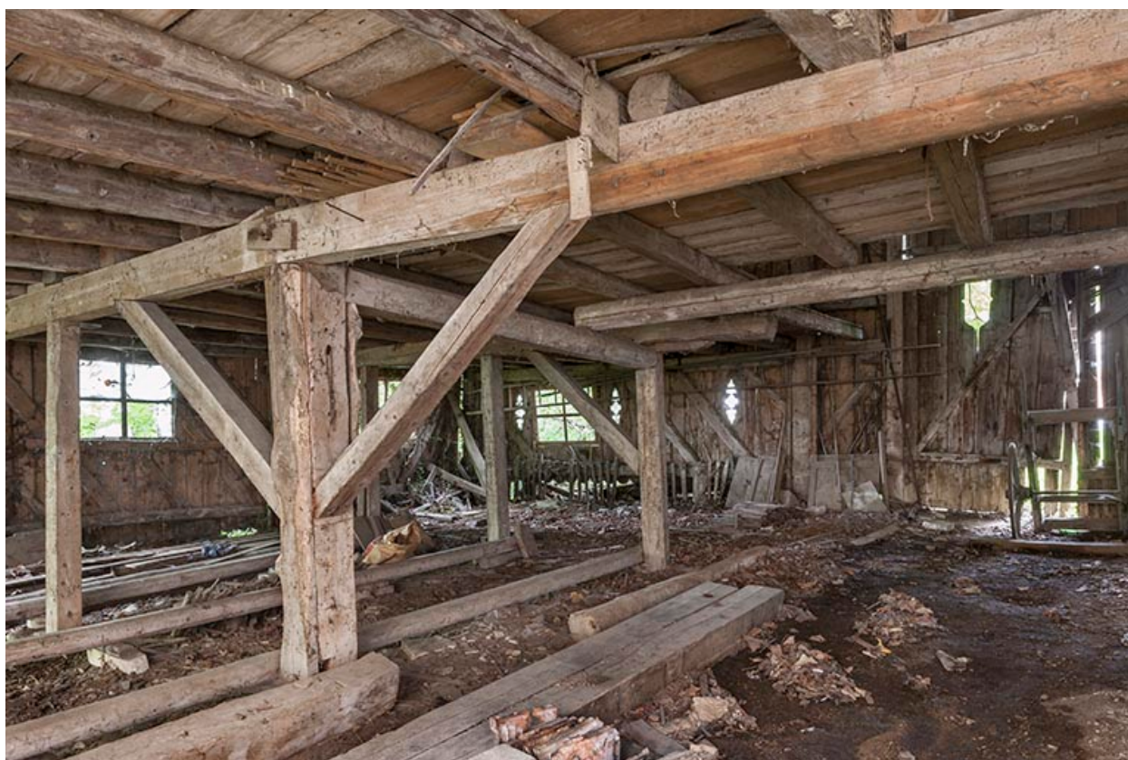
Entrepôt industriel. Rez-de-chaussée.
