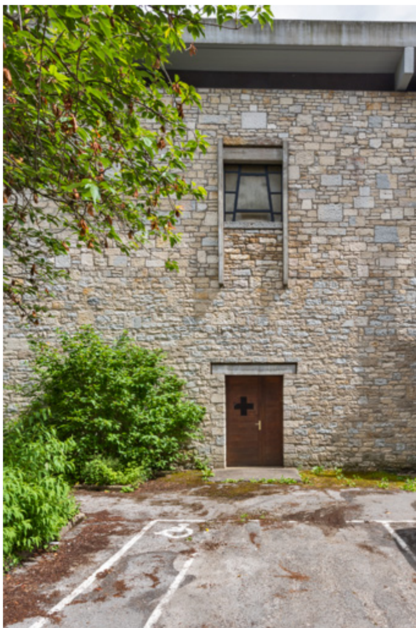
Porte extérieure donnant accès au dépositaire surmontée d'une baie.
