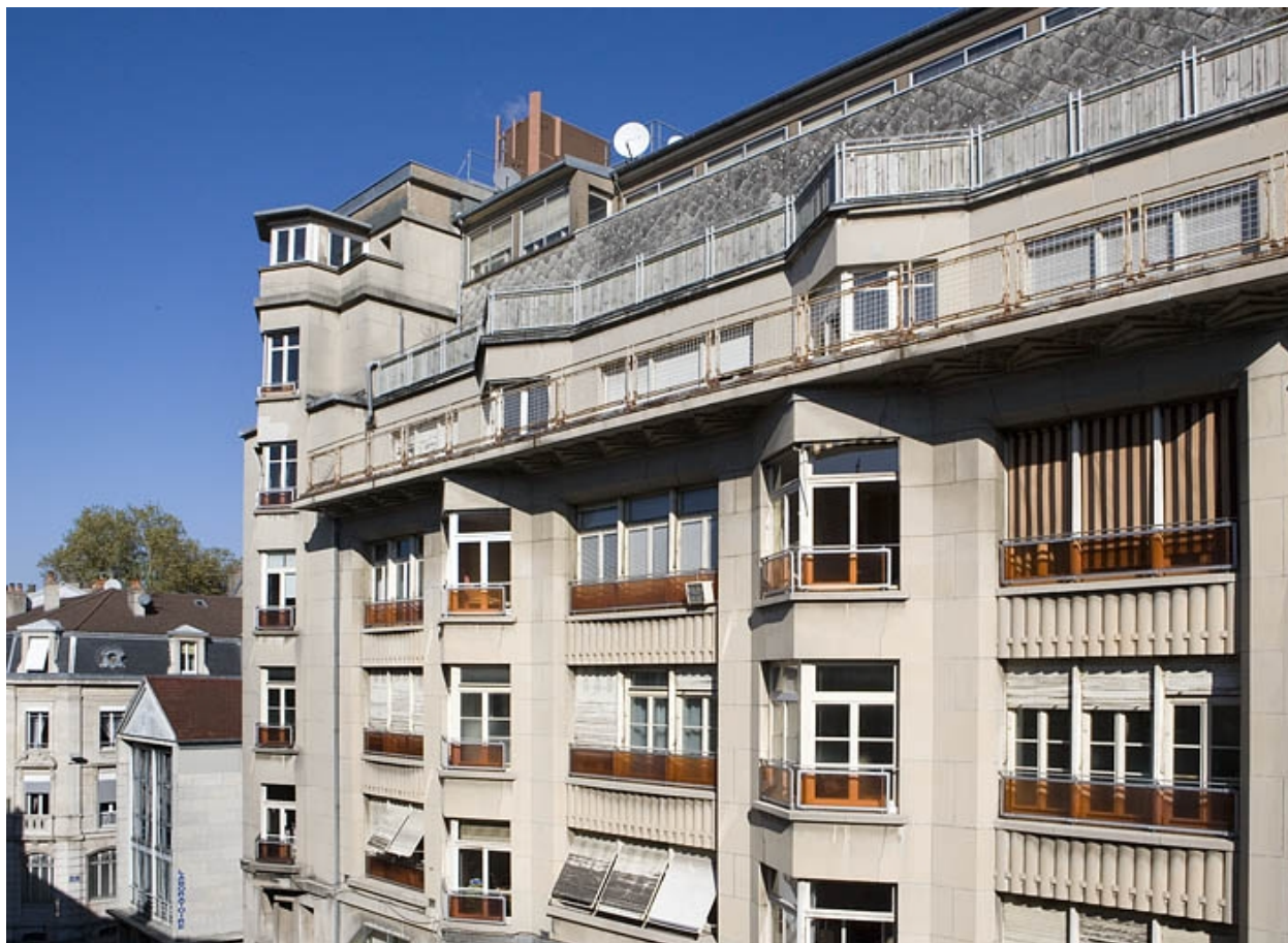
Façade antérieure : détail des étages supérieurs.
