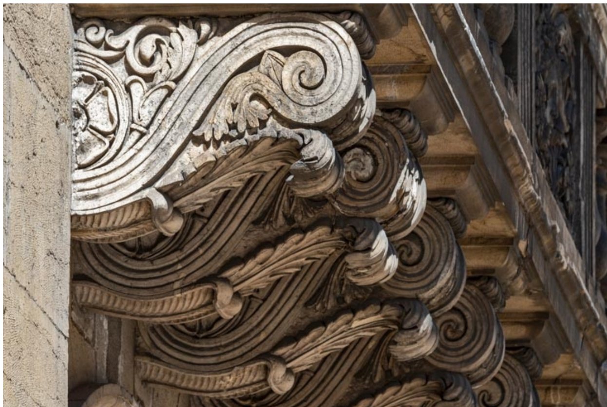
Façade antérieure : consoles du balcon.
