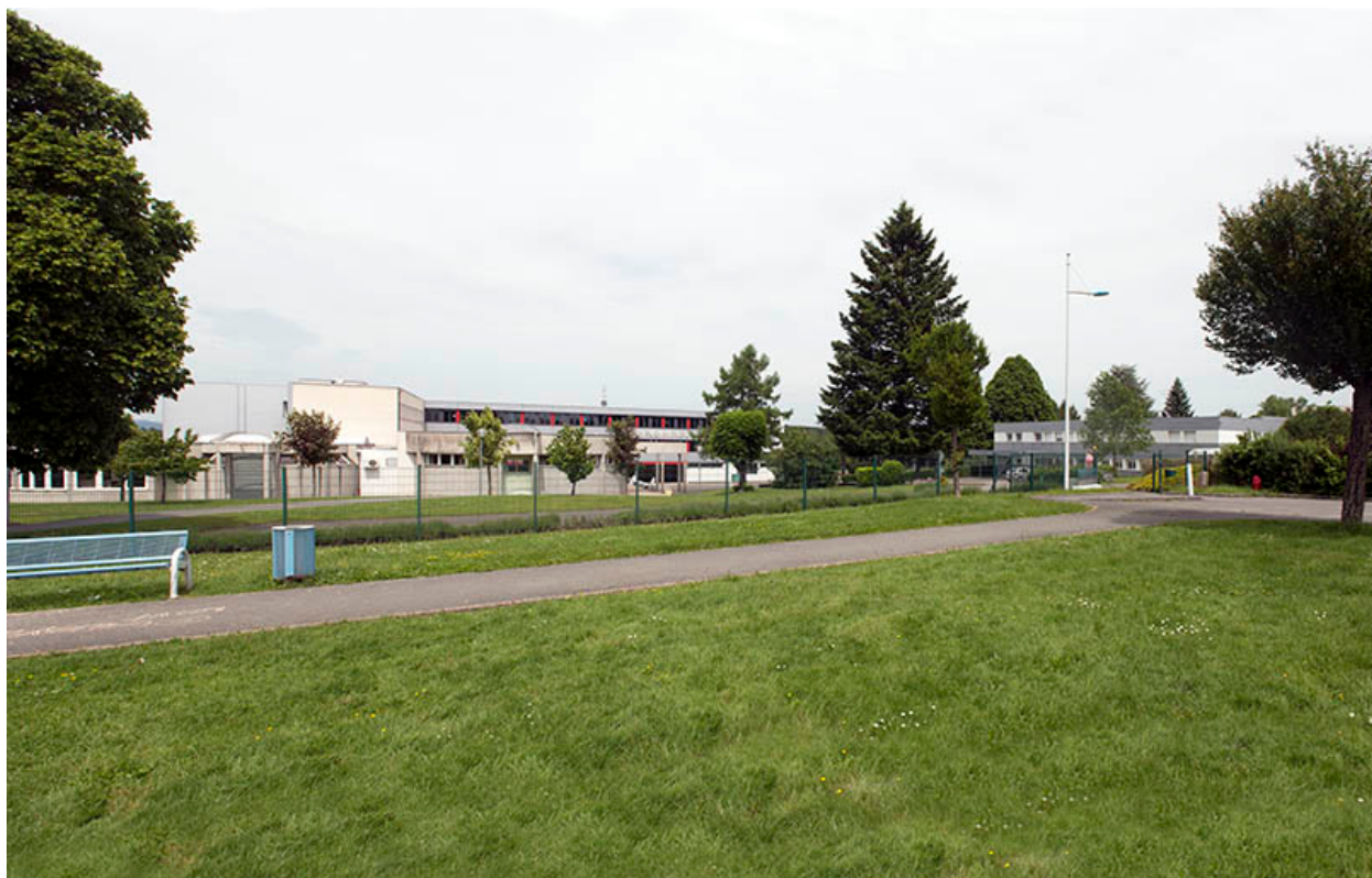
Vue d'ensemble depuis la placette au sud.
