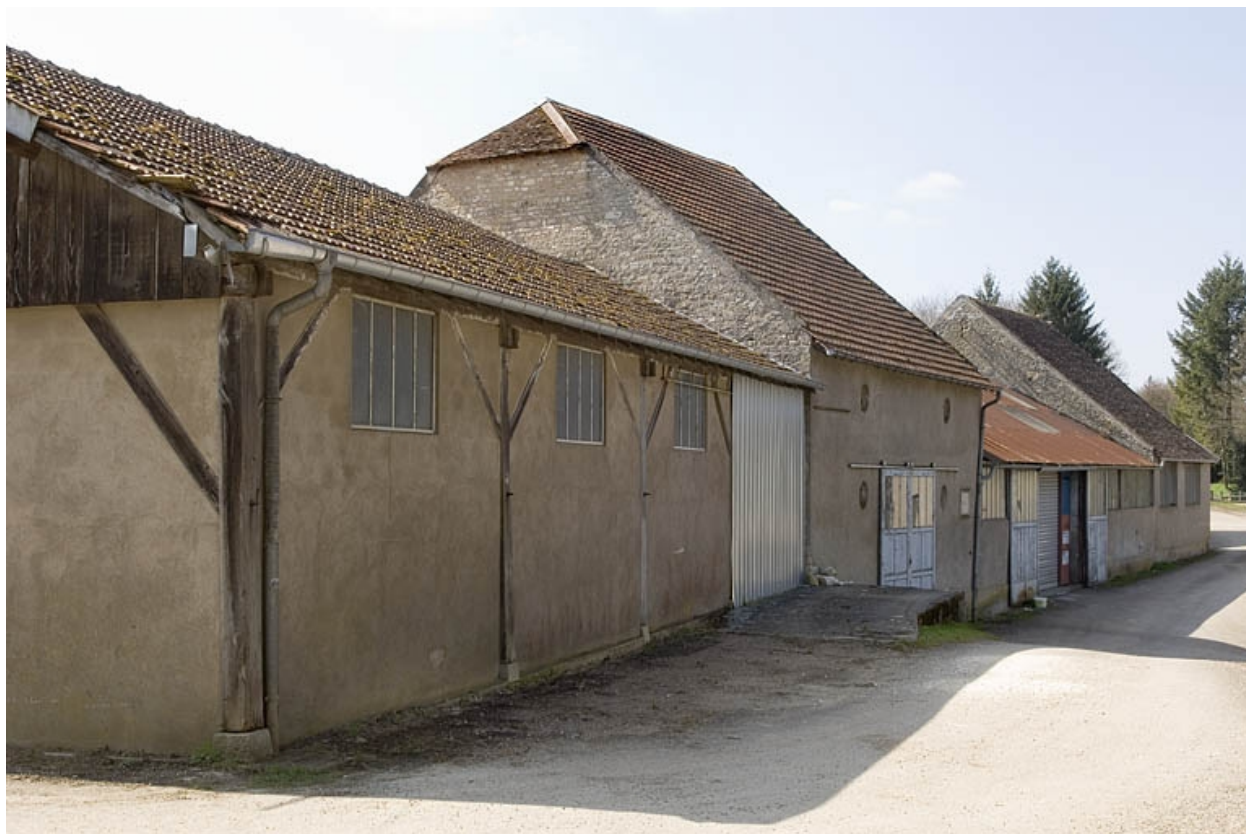
Façade nord de l'ancienne halle à charbon.
