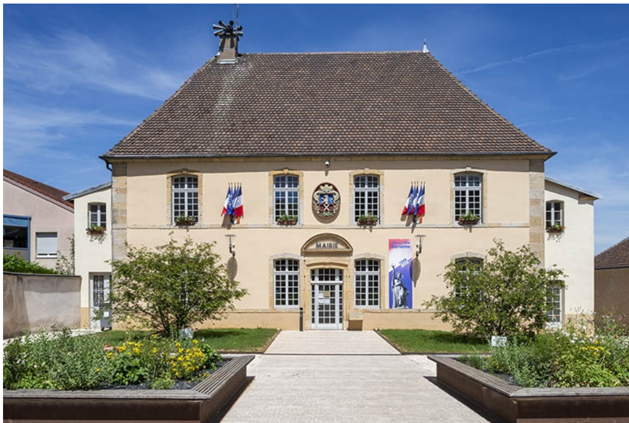
L'ensemble de la façade sud.
