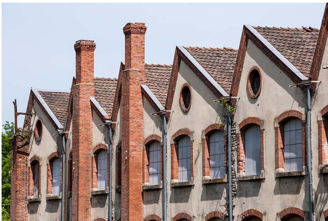
Détail des pignons de l'atelier de fabrication.
