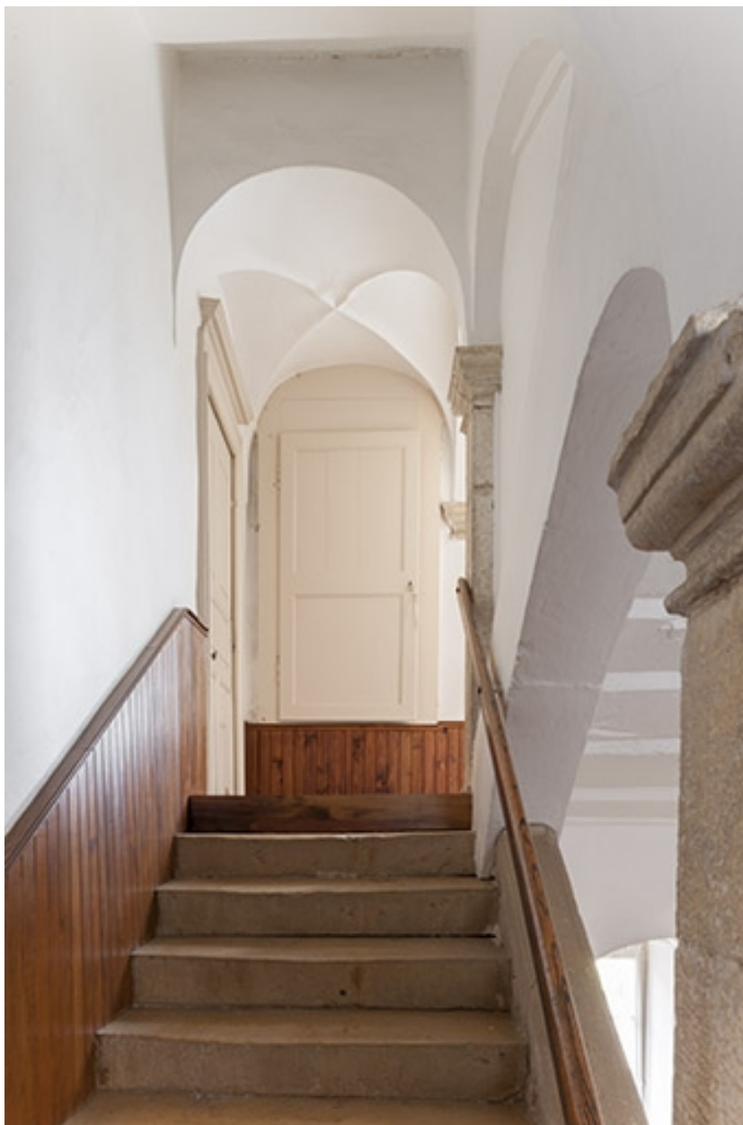
Escalier intérieur conduisant à l'étage.
