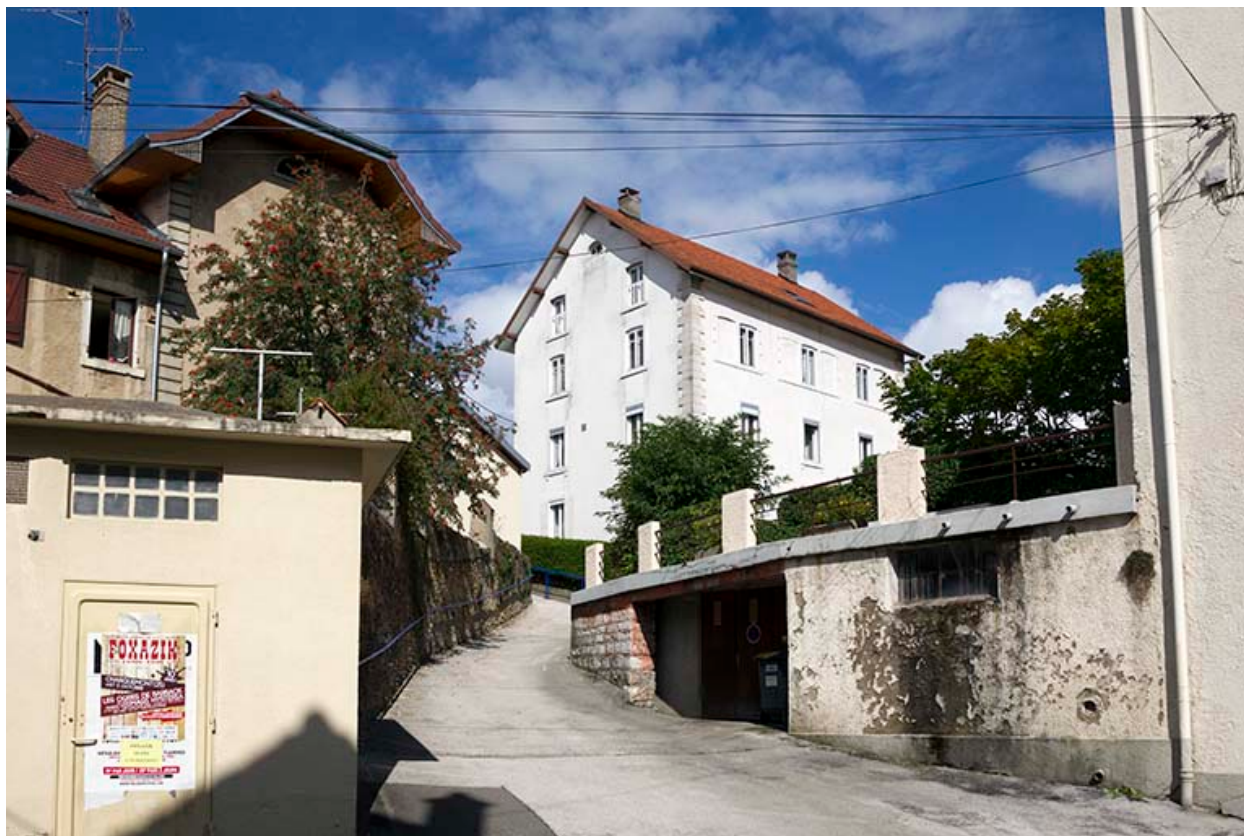
Façades postérieure et latérale droite.
